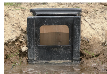
調整板の様子
